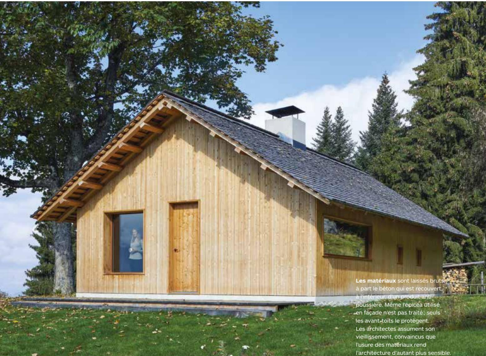
Les matériaux sont laissés bruts, à part le béton qui est recouvert, à l'intérieur, d'un produit anti-poussière. Même l'épicéa utilisé en façade n'est pas traité ; seuls les avant-toits le protègent. Les architectes assument son vieillissement, convaincus que l'usure des matériaux rend l'architecture d'autant plus sensible.
